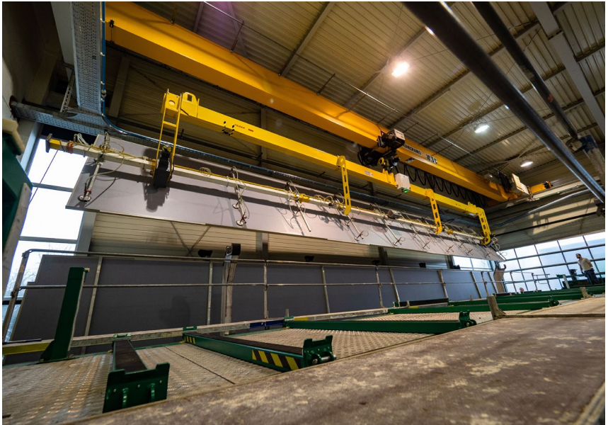
Abb. 10 Transport einer Blechtafel aus sicherer Entfernung mit Vakuumheber
