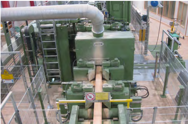
Abb. 12 Zentriereinrichtung mit jeweils seitengerichteter Überwachung – ob Schließung nach Durchlauf des Werkstücks erfolgt ist
