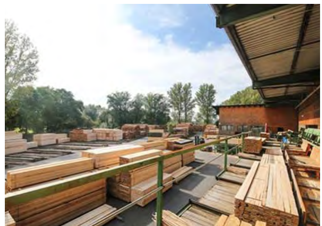
Abb. 52 Geländer mit herausnehmbarer Knieleiste zum Abtransport des Schnittholzes
