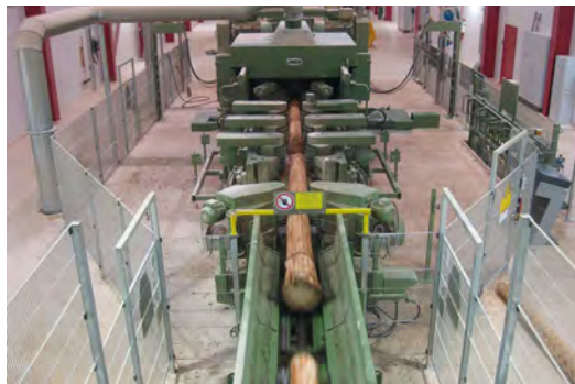
Systemeinzugs- und Zentriereinrichtung vor dem Spaner, Ventilblöcke außerhalb des Gefahrbereichs sowie Gefahrbereichstrennung innerhalb der Anlage
