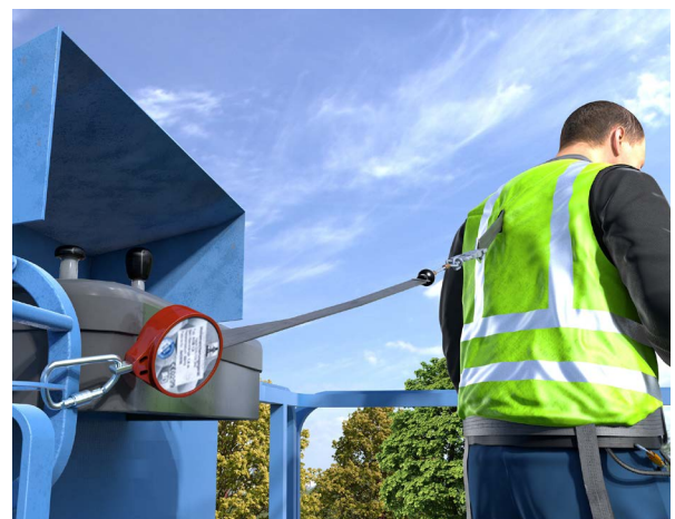
Abb. 9 Einsatz eines Höhensicherungsgeräts im Arbeitskorb
